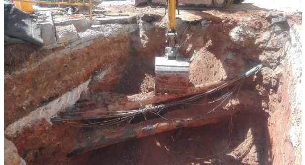
2. Serveis descoberts durant l'obertura del pou per a la construcció de l'arqueta.
