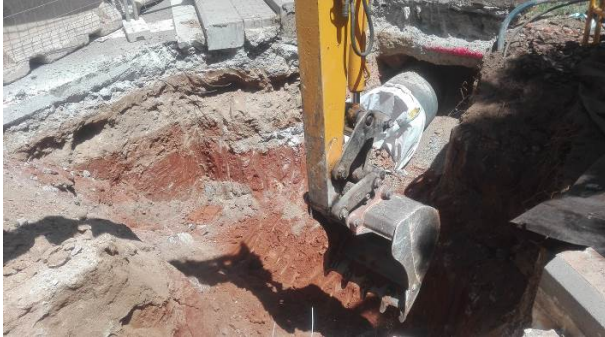
1. Obertura del pou per a la construcció de l'arqueta de formigó armat.
