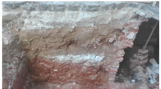
10. Detall on s'aprecia l'antic paviment d'asfalt i com pugen la cota de circulació fins al nivell actual.
